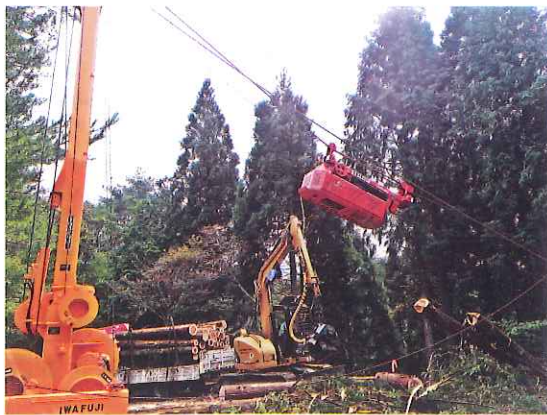
タワーヤードによる搬出状況
