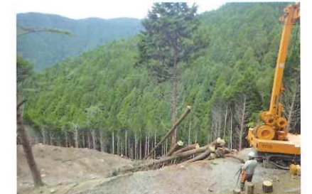
タワーヤーダによる集材
